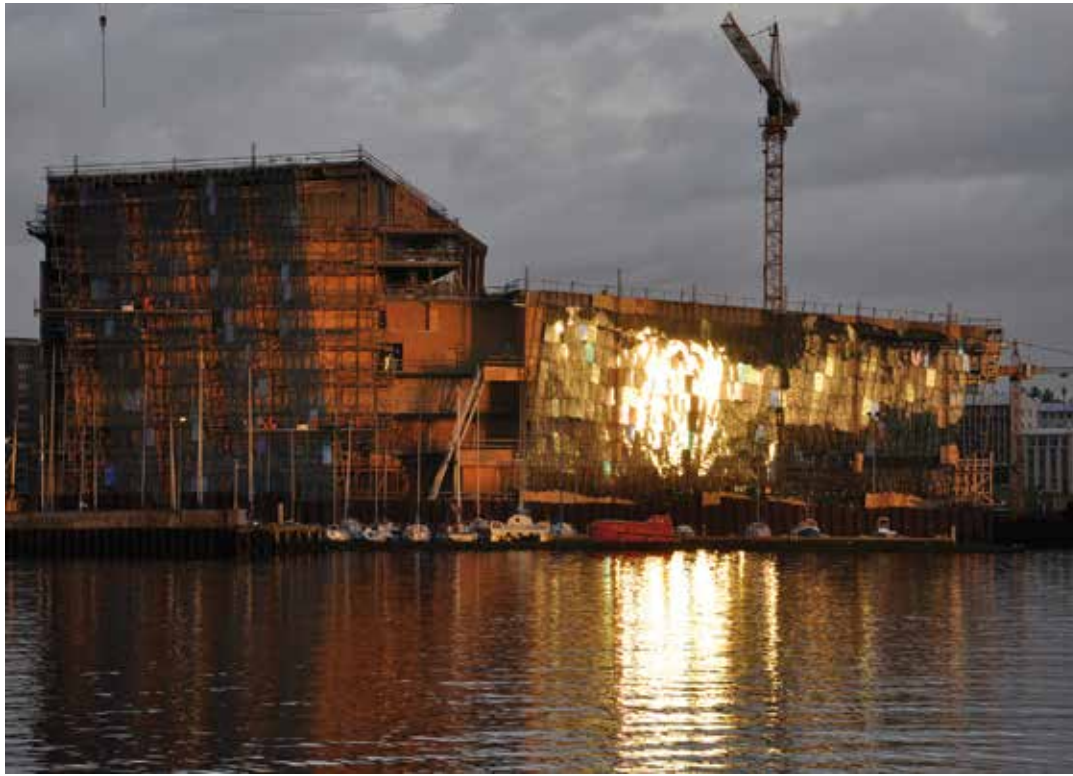
immagini della realizzazione images of the realization
