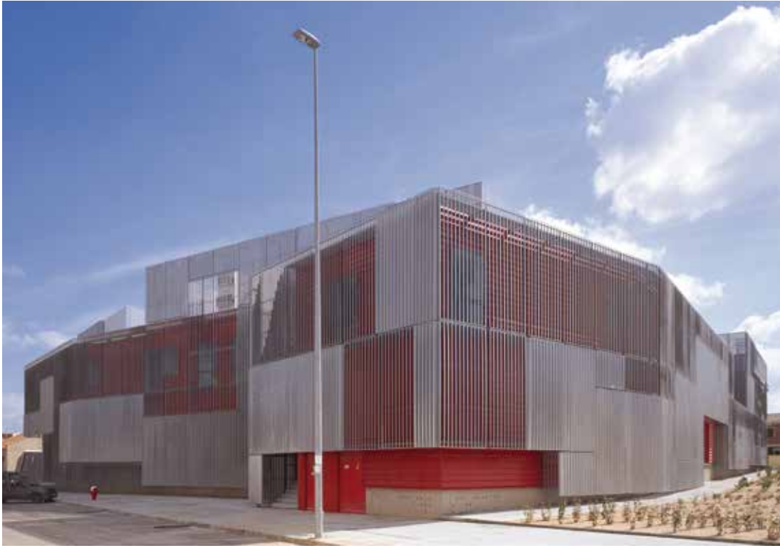
viste d'insieme dell'edificio total views of the exterior
