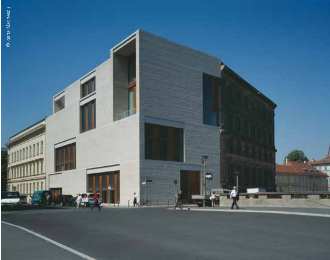
Am Kupfergraben 10, esterno Am Kupfergraben 10, exterior
