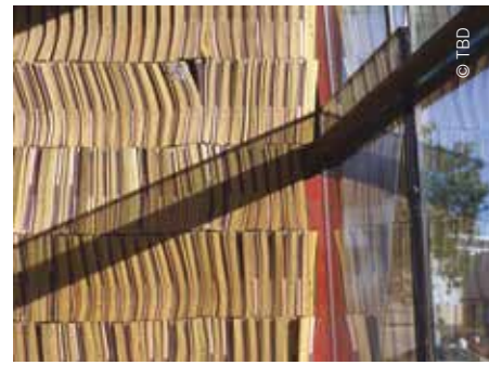
vecchi elenchi telefonici usati come parete interna assicurano isolamento e abbattimento acustico/old phonebooks as interior wall provide insulation and sound dampening
