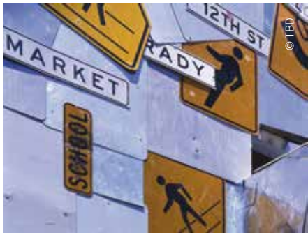
segnali stradali e lastre di zinco come rivestimento esterno/road signs and zinc sheet metal scraps as exterior cladding
