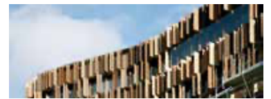
EDIFICIO PER UFFICI U15
